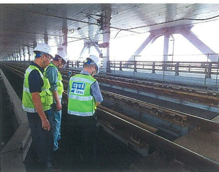
韩国仁川机场线（联络桥）
