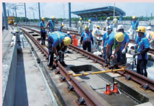
● スラブ実技研修 (台湾高速鉄道) ●
