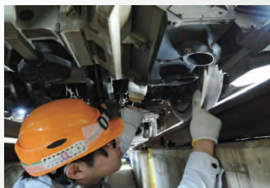
● 変位検出器の点検 / 検測車 ●
